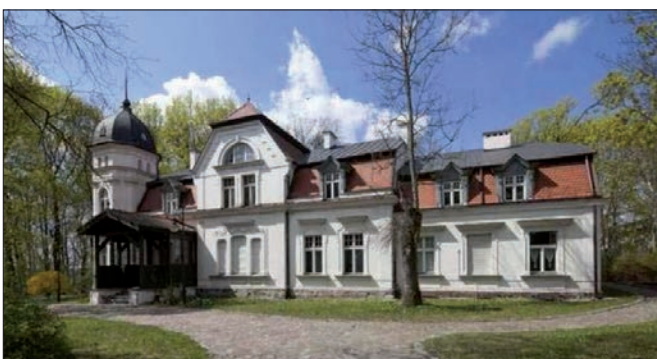
Das Gutshaus Bergenthal in Allenstein nach der Renovierung. Heute Naturkundemuseum in Allenstein. Foto MP Olsztyn
