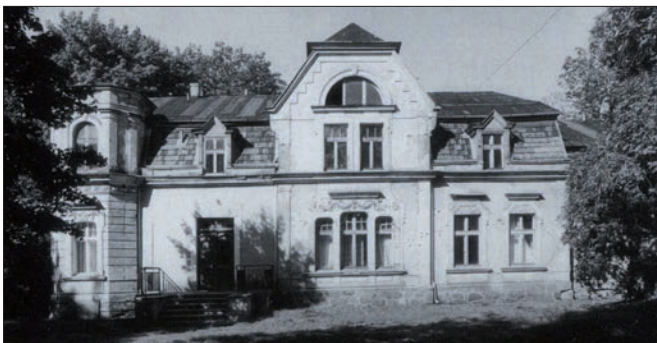
Das Gutshaus Bergenthal in Allenstein vor der Renovierung. Foto WKZ Olsztyn
